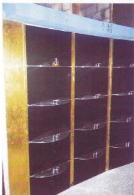
Krypty, przysłonięte na razie prowizorycznymi płytami z tworzywa.
